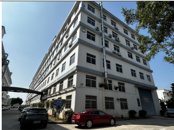
西面：园区 C 栋厂房
