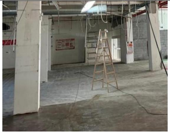
项目空厂房照片
