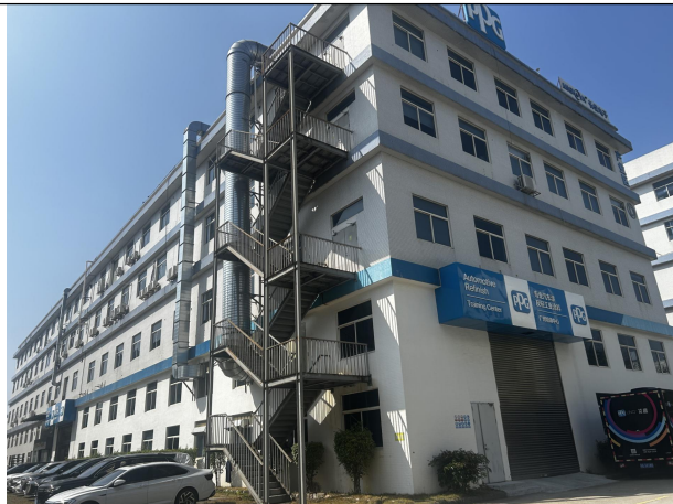
西南面：园区 D 栋厂房
