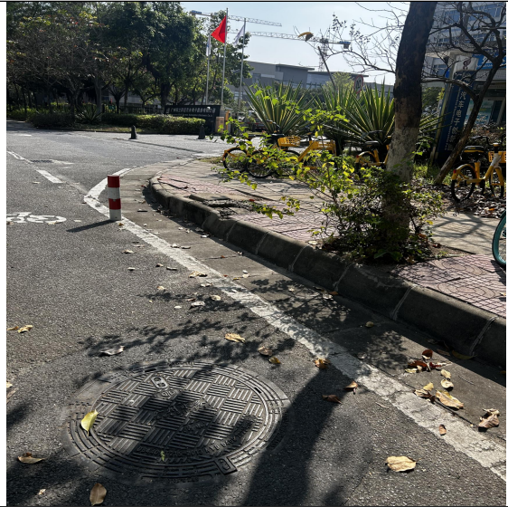
项目所在地污水井盖远照
